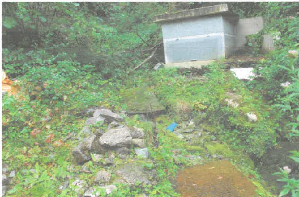
En arrière plan le nouveau captage et sa vidange. Au premier plan, à droite, le couvercle de l'ancien captage dont on voit la canalisation d'alimentation au milieu du cliché. Le tout servant maintenant de trop plein à la source. A gauche du cliché on peut voir un bag de chantier abandonné avec d'autres déchets au milieu d'une végétation exubérante. Depuis, le PPI a été nettoyé.
