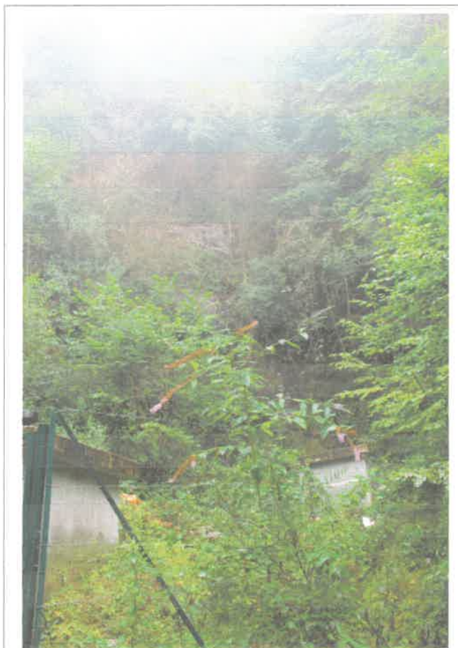
Vue de la paroi au pied de laquelle jaillit la source et vue partielle du PPI et des ouvrages de captage
