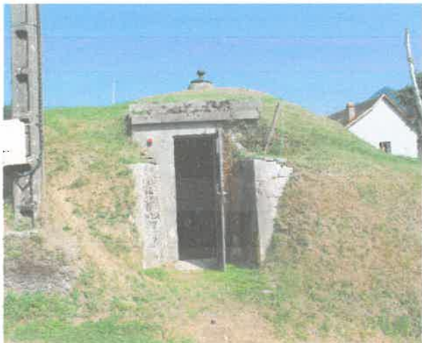
Entrée du réservoir par porte sécurisée et capot-regard avec cheminée FOUG sur le dessus.
