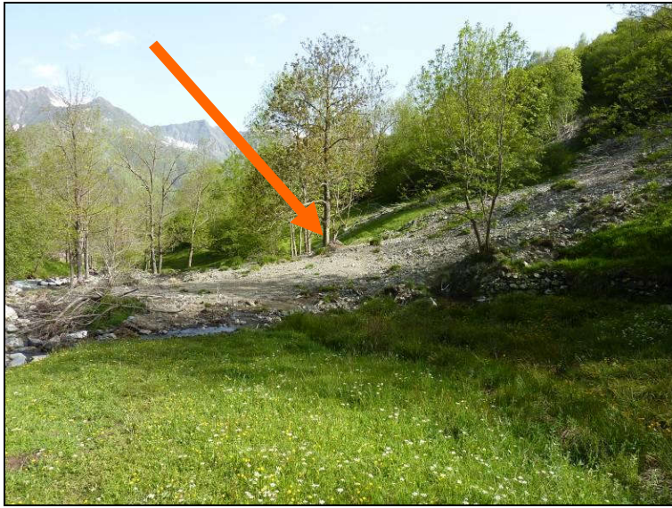
Glissement de terrain 2014
