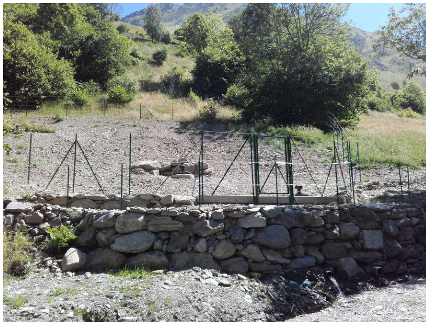
Figure 4. Accès à l'ouvrage de captage par un portillon (Source: ANTEA 2016)
