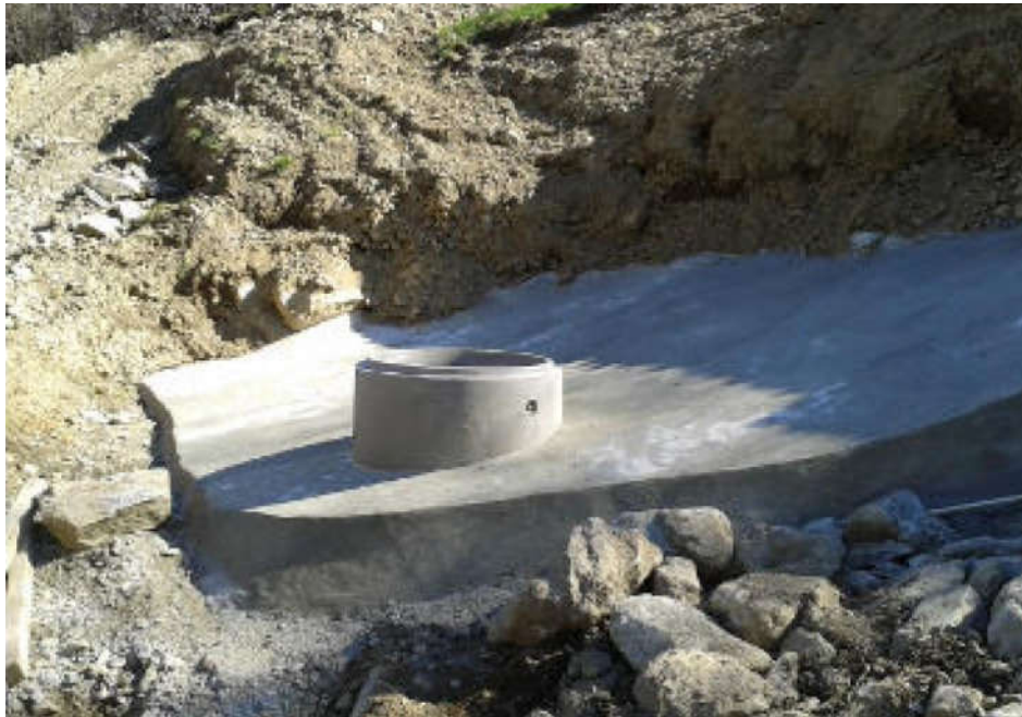
Figure 17. Photographies des travaux du captage aménagé de la source Armary Nogué -04/05/2016 (Source : ANTEA)
