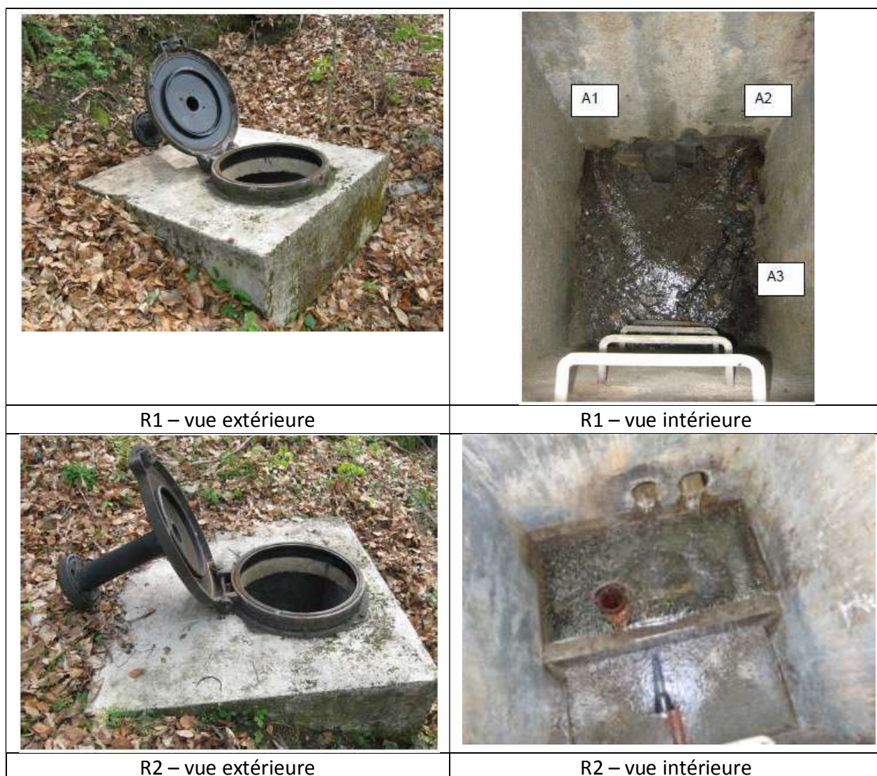
Figure 12 : photographies des ouvrages de Lacarret
