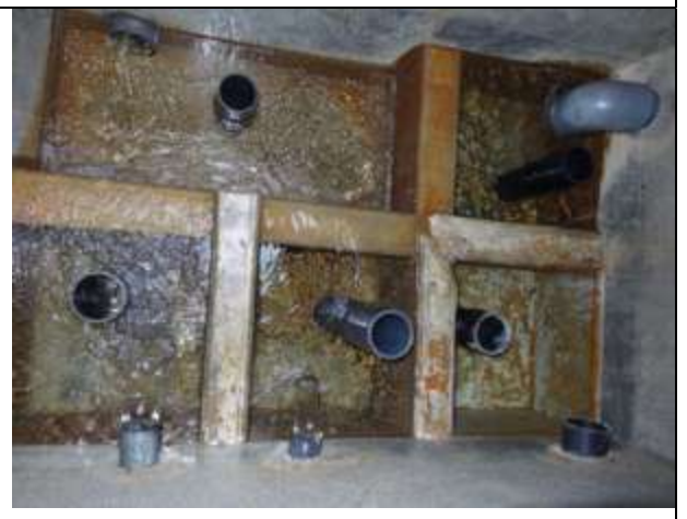
R2 – vue intérieure
