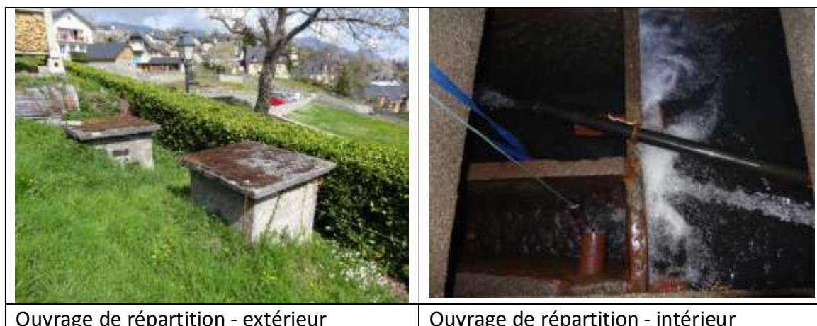
Figure 13 : photographies des ouvrages de répartition
