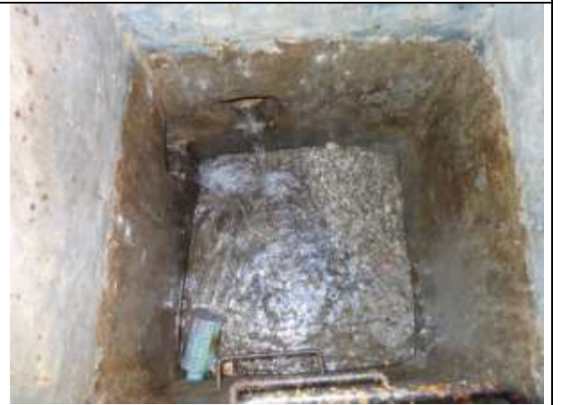
R1b – vue intérieure
