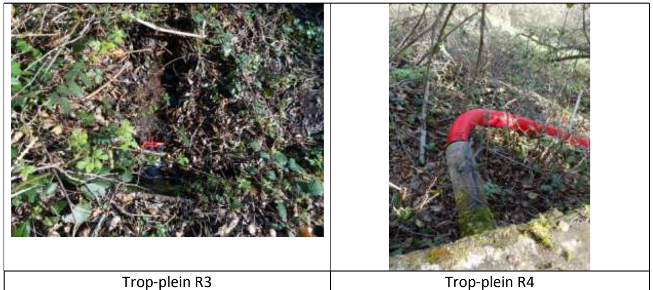
Figure 10 : photographies des ouvrages de captage de Hounta Sourde
