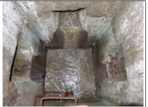
R1 – vue intérieure
