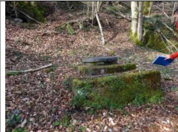
R1 – vue extérieure
