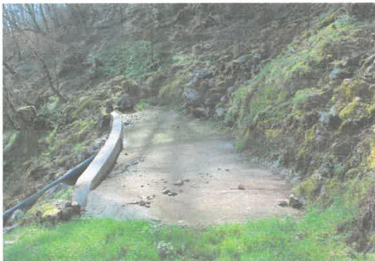
Ouvrage maçonné et tuyau de drainage des éboulis au dessus du captage
