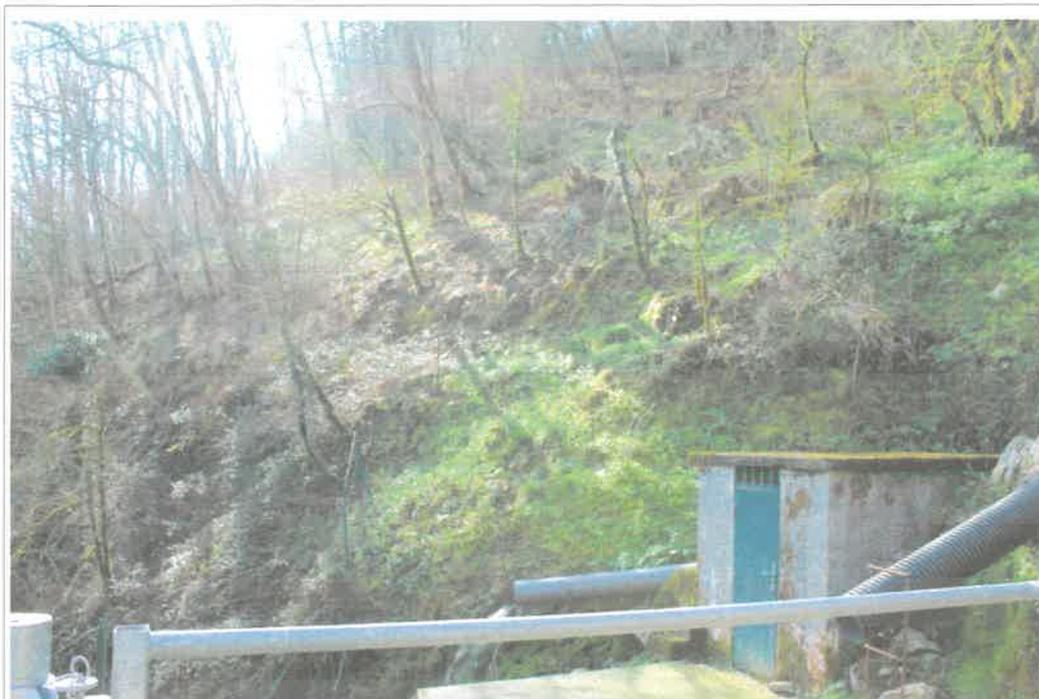
**Chambre de captage avec son trop plein muni d'un clapet et le tuyau du drainage (à droite du cliché) au premier plan vue partielle d'un des deux portails d'accès**
