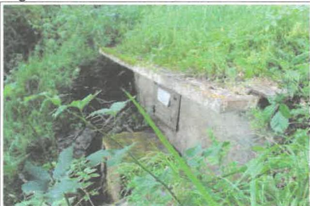
Partie visible de la chambre de captage basse dont la maçonnerie a été dégradée par les écoulements des griffons. La grille de ventilation se dégrade également
