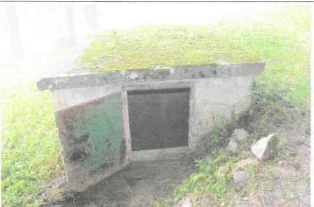
Situation après nettoyage des abords. Il serait nécessaire de procéder à une restauration de la porte et à la préservation de la maçonnerie.
