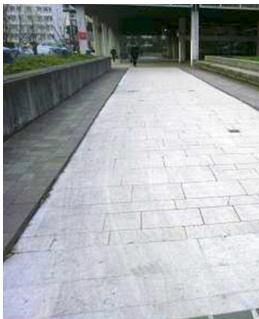
Illustration 6 : Cheminement intuitif existant. Source : Cerema/DTerCE - Parvis du Grand Lyon
