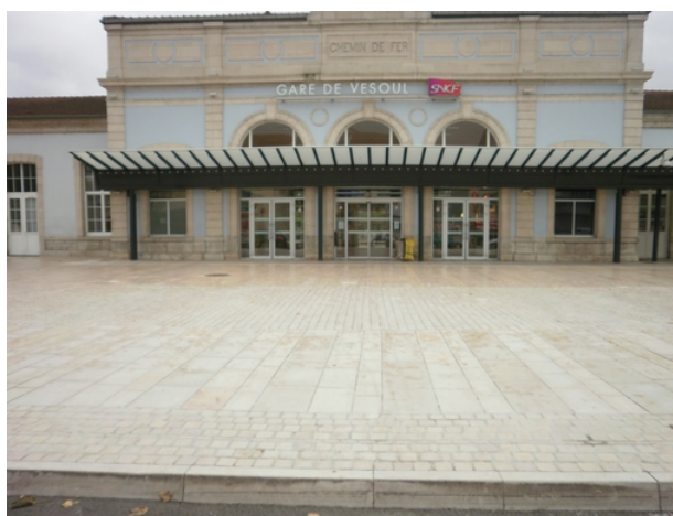
Illustration 7 : Repères insuffisants pour un guidage intuitif. Source : Cerema/DTerCE – Parvis de la gare de Vesoul
