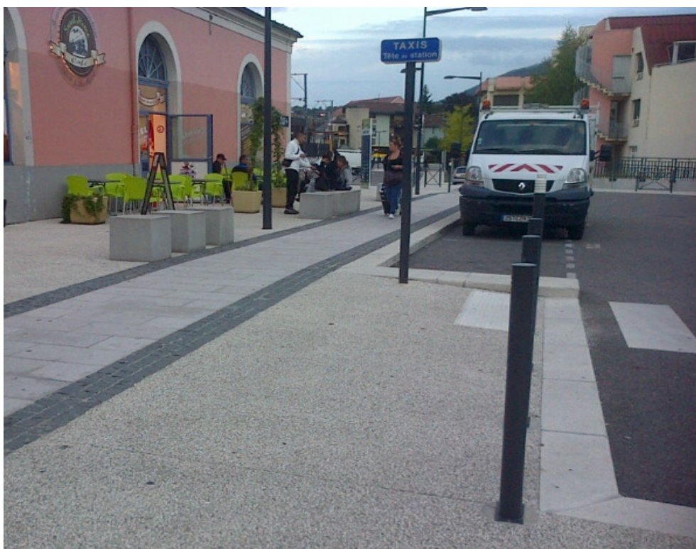
Illustration 3 : Guidage intégré dès la conception repérable et détectable. Source : B. Bruas, Voiron
