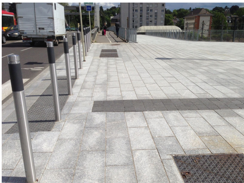
Illustration 15 : Interception sur le cheminement principal sans guidage menant à une traversée piétonne.
