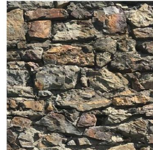
03 - Murs en pierre identiques aux existant
