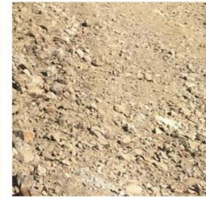
02 - Remblai terrasses arrière + Est constitué de débris concassés sur site
