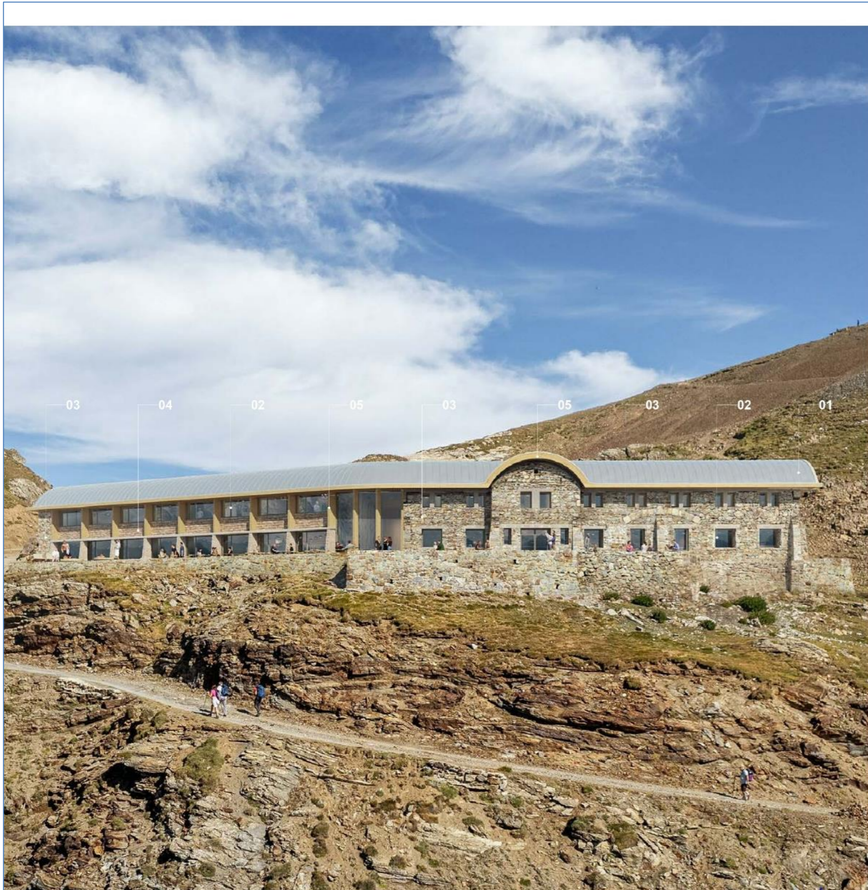
01 - Couverture inox du bâtiment
