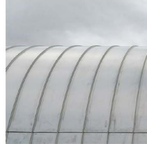
01 - Couverture inox du bâtiment
