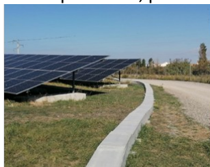
Les ouvrages ne doivent pas créer d'effet « digue », à l'instar de ce passage de câbles béton ( ci-dessus). Ils laissent l'eau s'écouler naturellement (ci contre).
