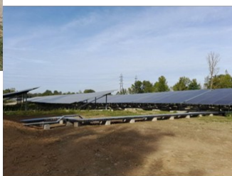
Les ouvrages ne doivent pas créer d'effet « digue », à l'instar de ce passage de câbles béton ( ci-dessus). Ils laissent l'eau s'écouler naturellement (ci contre).
