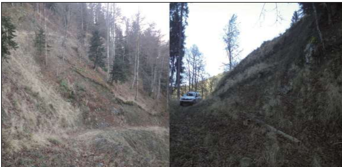
Figure 9 : Glissements dans la piste de Bios (source AGERIN)
