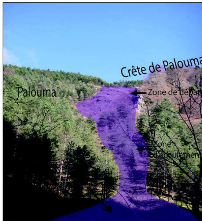
Figure 15 : Vue sur le couloir de Paloum depuis la RD7 (source AGERIN)
