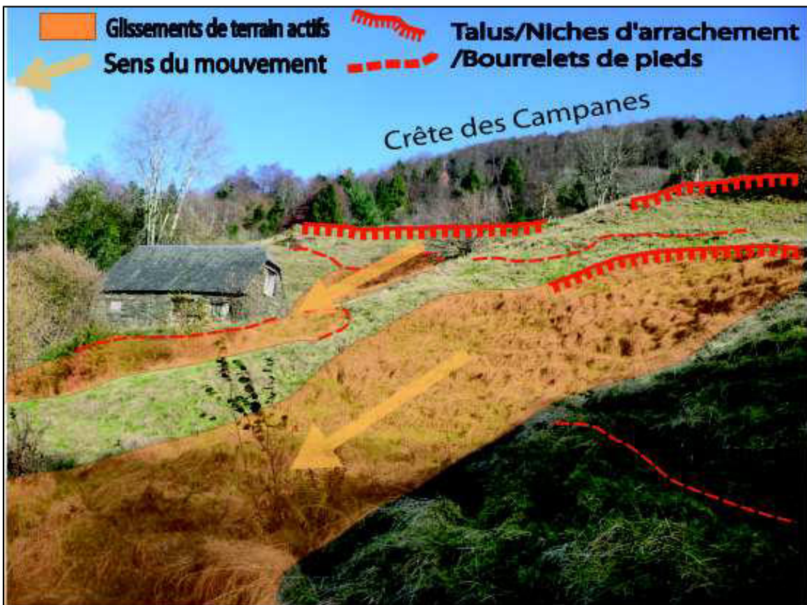
Figure 8 : Loupe de glissement au niveau dans les formations morainiques (source AGERIN)
