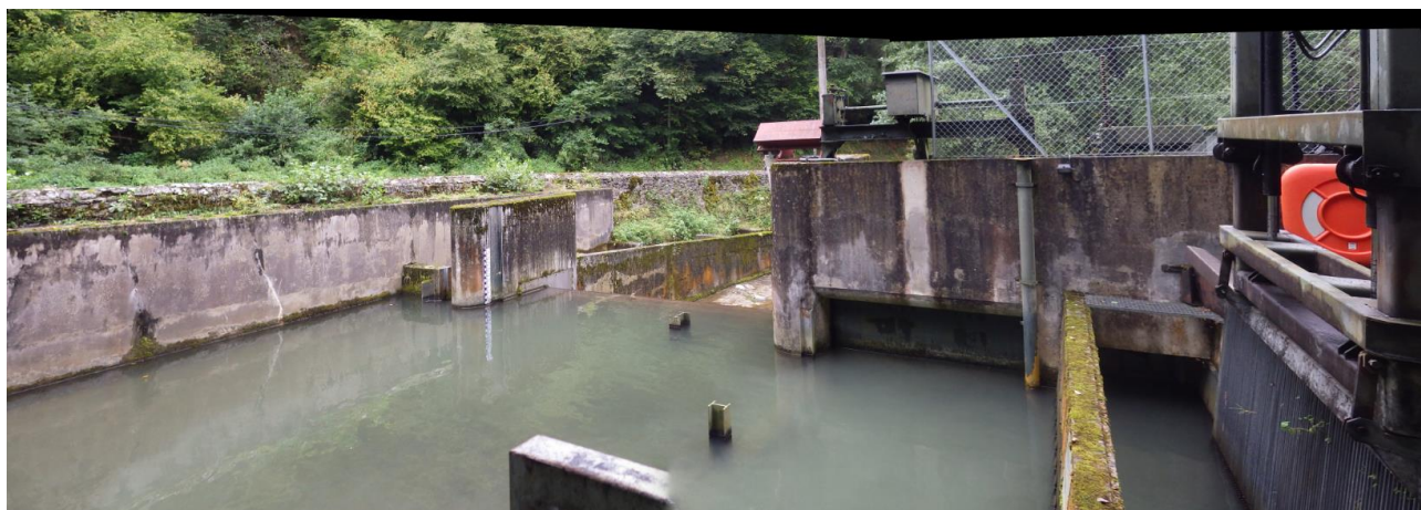
Figure 2 - Vue depuis l'amont du barrage : plan d'eau, passe à poisson en RG, prise d'eau en RD
