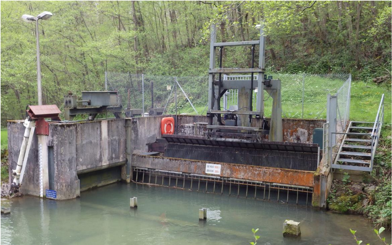
Figure 50 - Prise d'eau actuelle : pré-grilles et plan de grilles fines
