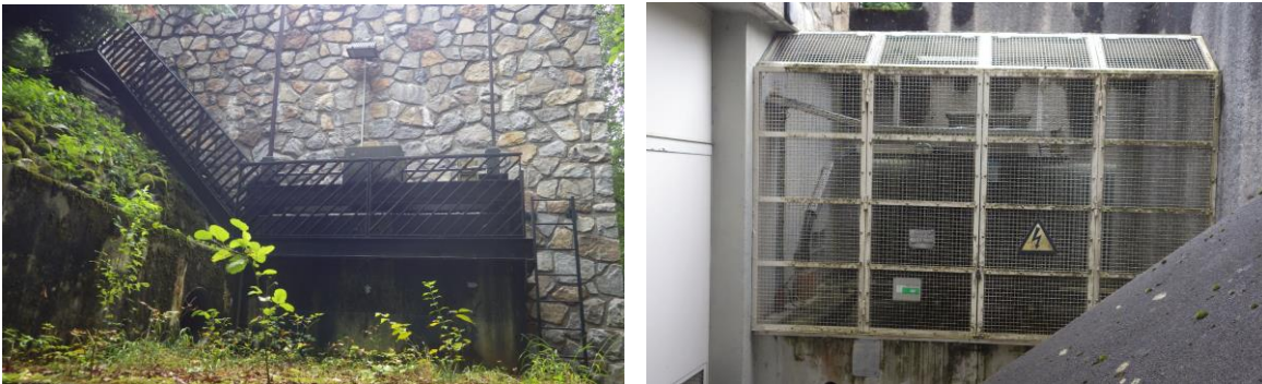
Figure 49 - Mise en sécurité en niveau du bâtiment de l'usine
