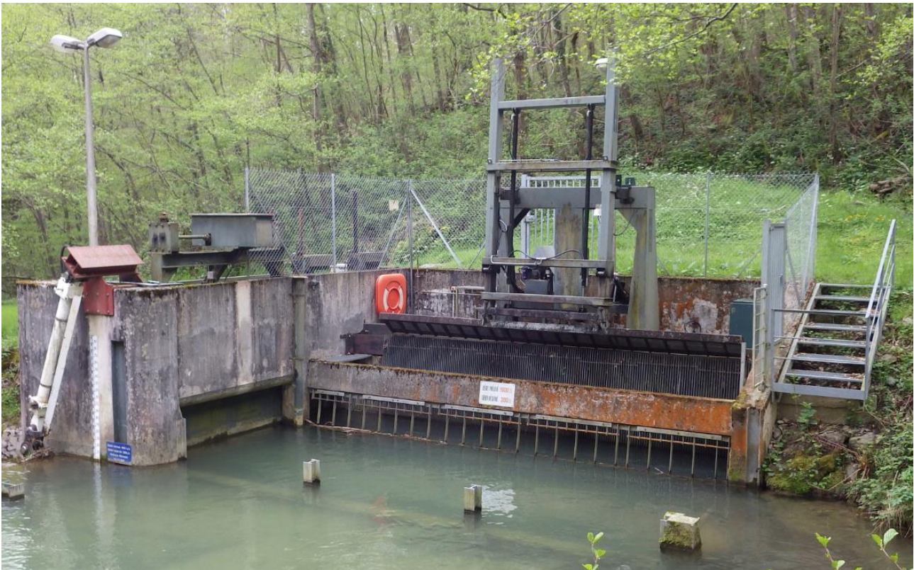
Figure 51 - Prise d'eau actuelle : pré-grilles et plan de grilles fines
