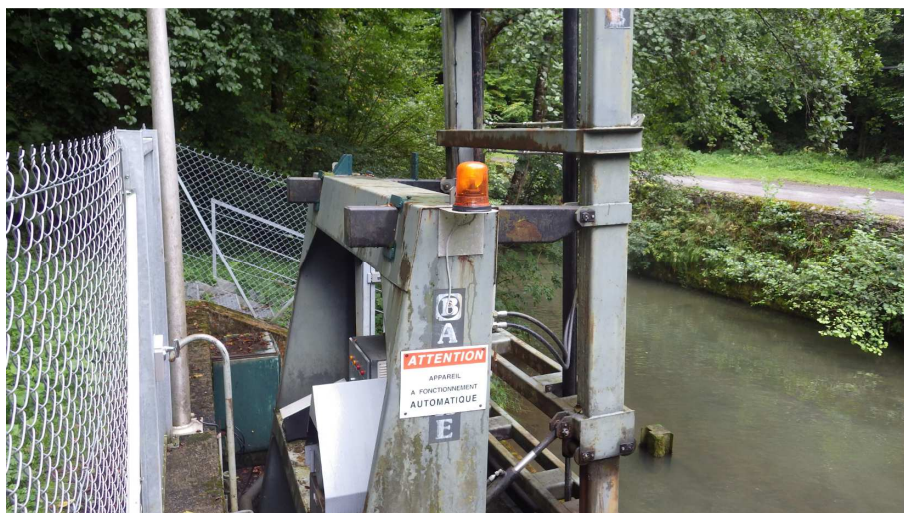
Figure 48 – Sécurisation actuelle de la prise d'eau vis-à-vis du public
