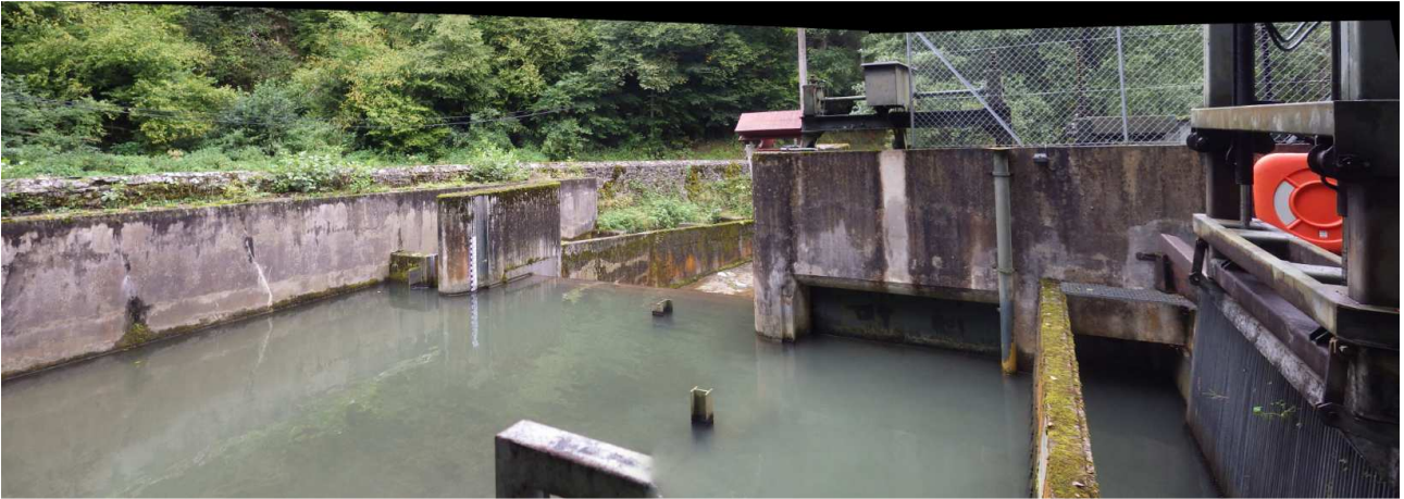
Figure 2 - Vue depuis l'amont du barrage : plan d'eau, passe à poisson en RG, prise d'eau en RD
