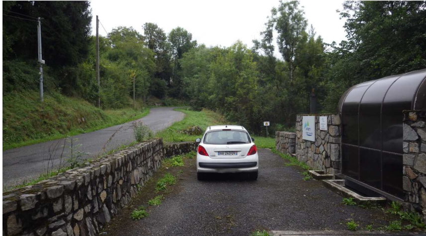
Figure 24 – Vue sur l'installation hydroélectrique existante dans le paysage environnant, depuis la route départementale D22
