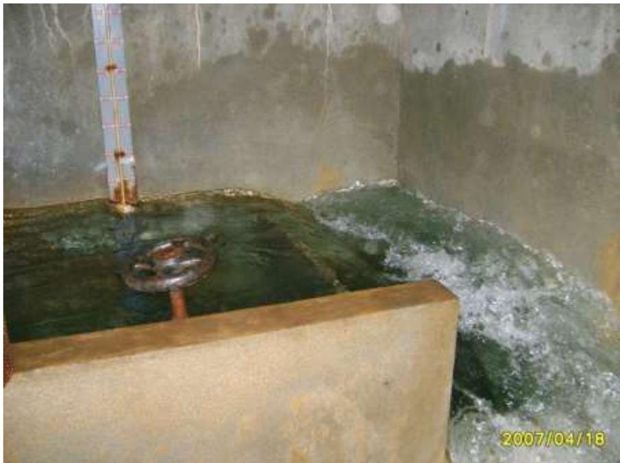
**Figure 6 : les ouvrages de la source de l'Homme (le bassin de mise en charge)**
