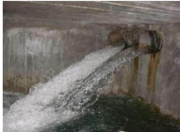
**Figure 6 : l'arrivée des eaux dans le bassin de mélange (débit plus important en provenance du captage oriental)**
