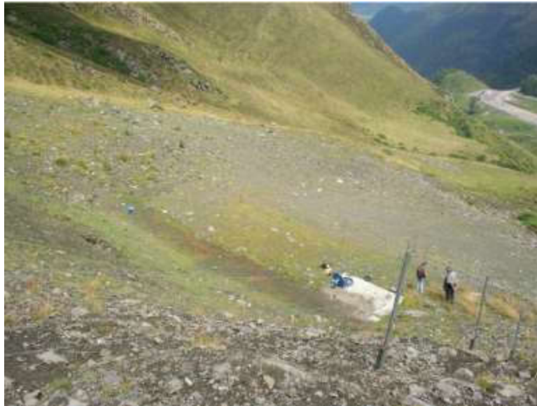
Figure 8 : la zone de captage de Clôt de Tarbes (ouvert, le tampon d'accès au bassin de collecte)
