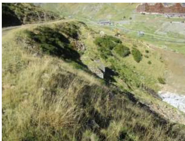
Figure 17 : captage oriental – source de Turon des Vaches
