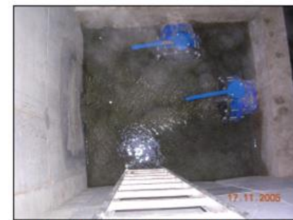
Chambre d'accès avec vidange de la galerie et trop plein en bas à droite
