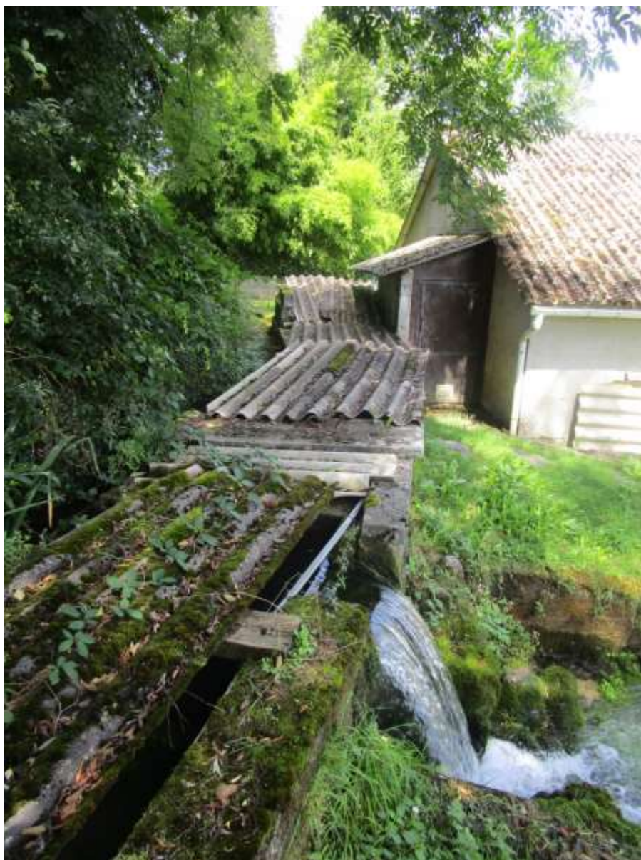
Figure 24 : Photo – canal d'évacuation du trop-plein de la source
