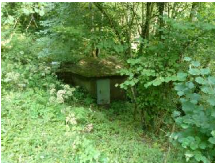
Figure 15 : vue du captage de l'Homme
