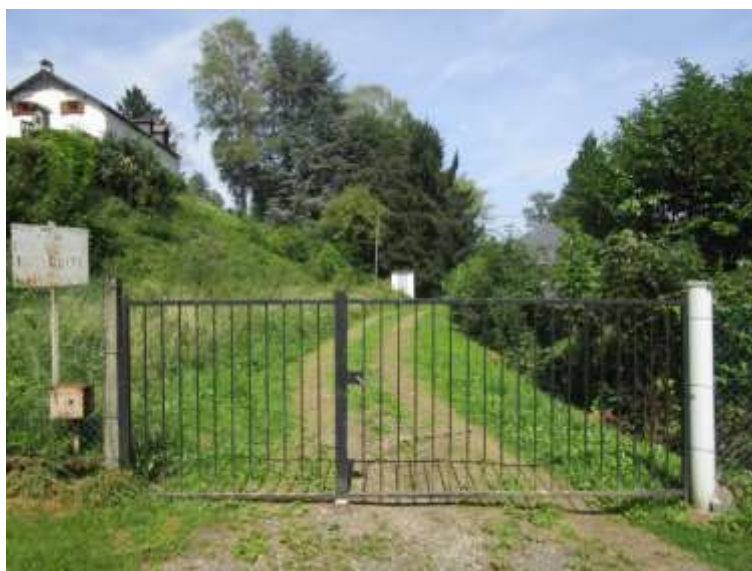
Figure 13 : vue du captage Hount negro depuis la voie sans issue
