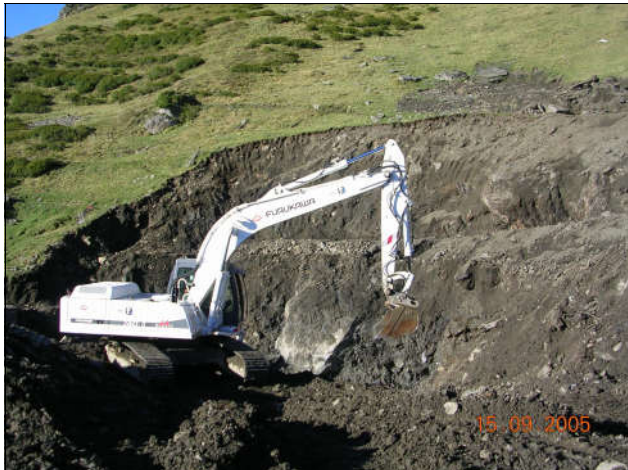
Fouille de dégagement
