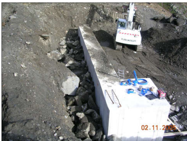
Mise en place de gros blocs au droit des barbacanes
