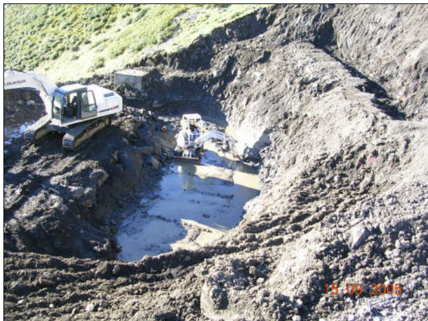
Fouille dégagée avec ancien captage au fond
