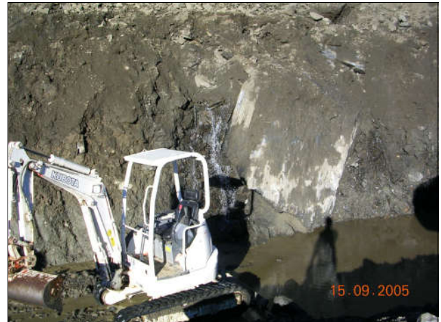
Principaux griffons autour du gros bloc
