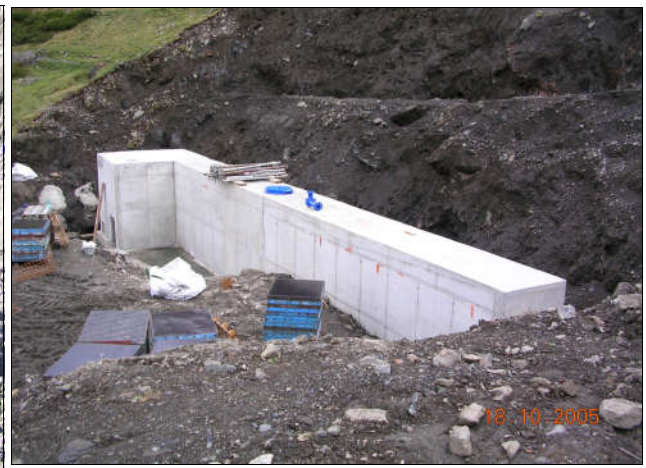
Ouvrage de captage terminé
