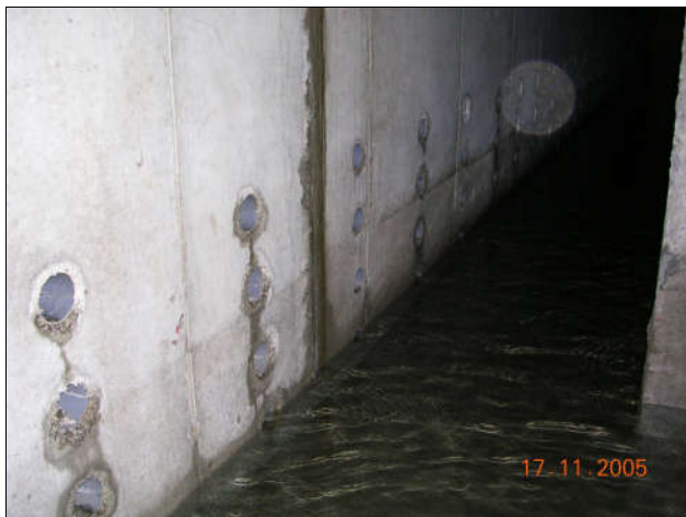
Galerie de captage avec 4 rangées de barbacanes (galerie en vidange)
