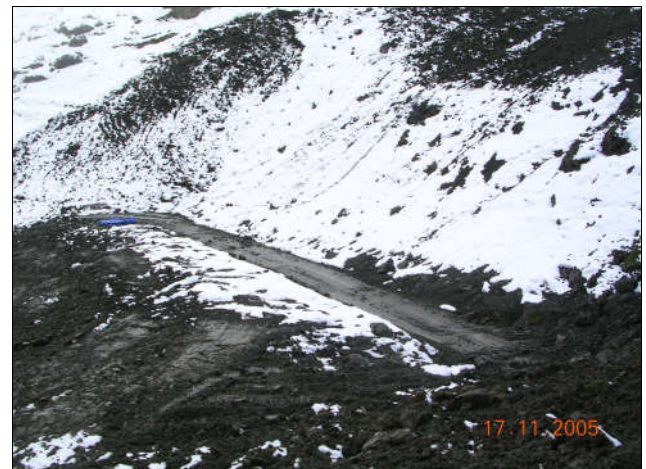
Ouvrage remblayé en novembre 2005
