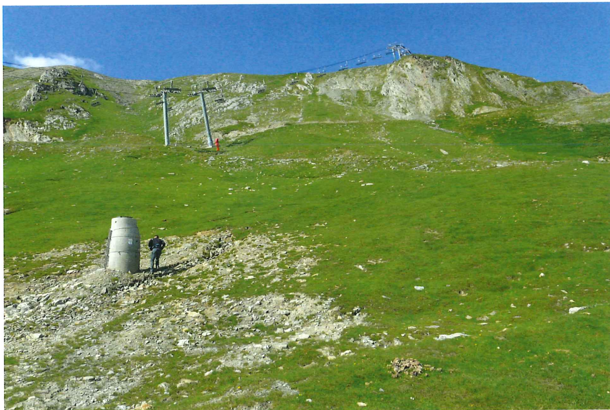
Ouvrage de captage de la source du Grum – 31 juillet 2018 – photo CE Mercier
