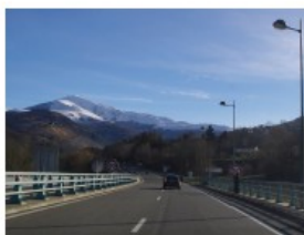
Voie rapide reliant Lourdes à Argeilès-Gazost
