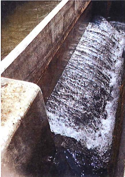
Entrée d'eau dans les bassins d'alevinage grâce à une fenêtre rectangulaire
