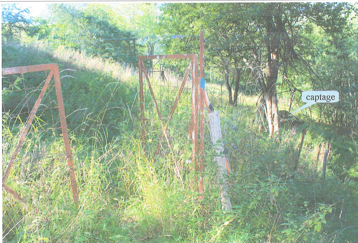
Vue partielle de l'enceinte du périmètre de protection actuel et d'un des deux accès. La chambre de collecte du captage est en partie basse
