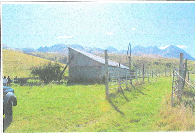
Secteur du PPR2 – Vue d'ensemble du bâtiment de contention et de l'aire de stabulation, propriété communale
