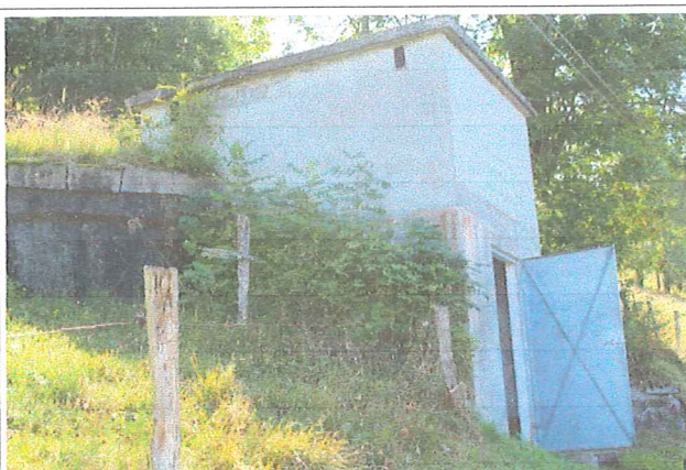
Réservoir communal d'une capacité de 50 m 3
