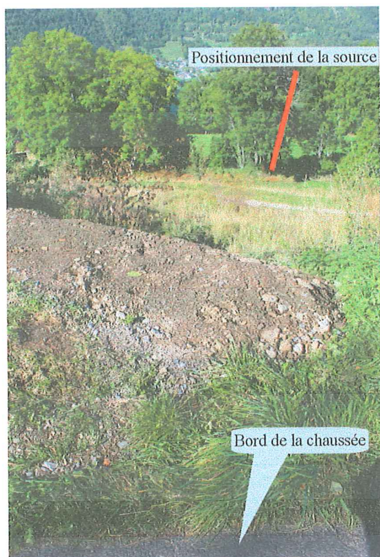
Lors de précipitations de l'eau ravine dans le PPR1 depuis le RD.618 La municipalité a aménagé un remblais pour y palier
