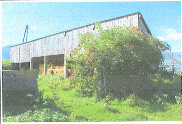
Le bâtiment de contention est utilisé pour l'entreposage de foin.
