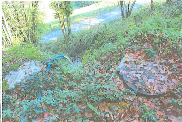
Vue supérieure du bassin de mise en charge et du réservoir. L'eau du captage s'écoule librement depuis le tuyau bleu. La végétation recouvre tout.
