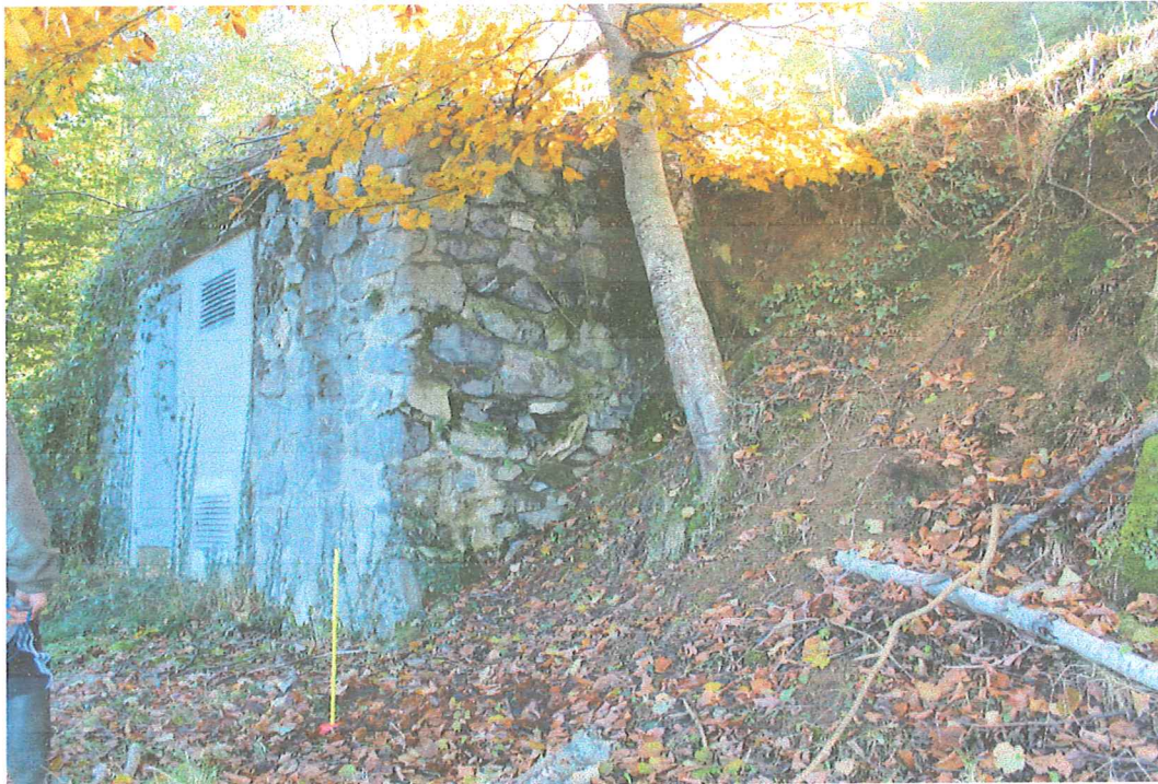
Vue du réservoir de Montjoye supérieur. Le piquet jaune au premier plan matérialise le bornage effectué par le géomètre.
