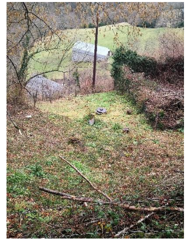
Vue du couvercle du regard depuis la partie haute du terrain
