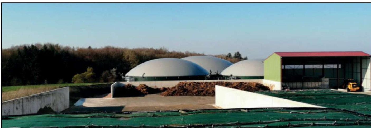
Exemple de deux digesteurs et un post-digesteur
